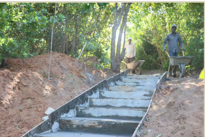
Eine Treppe für die Regenzeit
