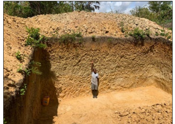
Aushub für einen Erdkeller
