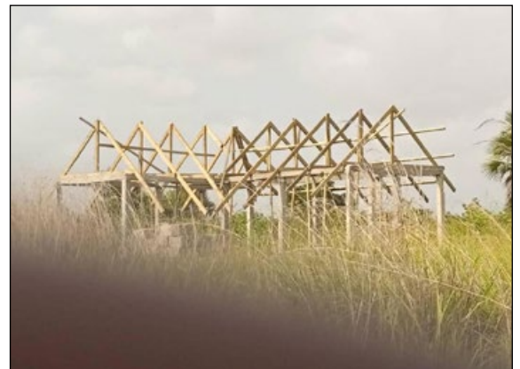
Dachstuhl für ein neues Heim
